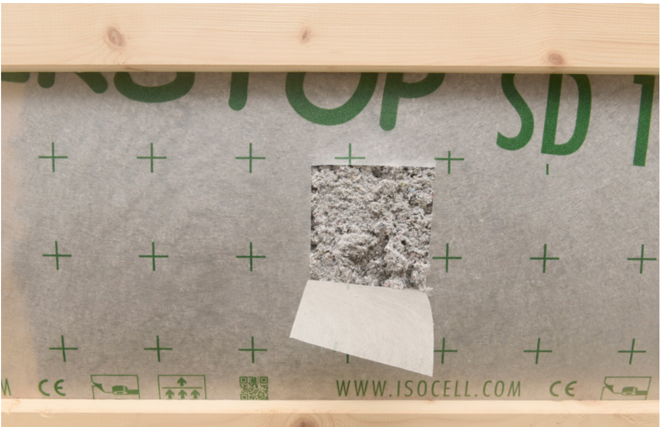
Das Loch im vollständig mit Zellulose gefüllten Gefach wird nach dem Einblasen luftdicht mit einem Dichtpflaster verschlossen.
