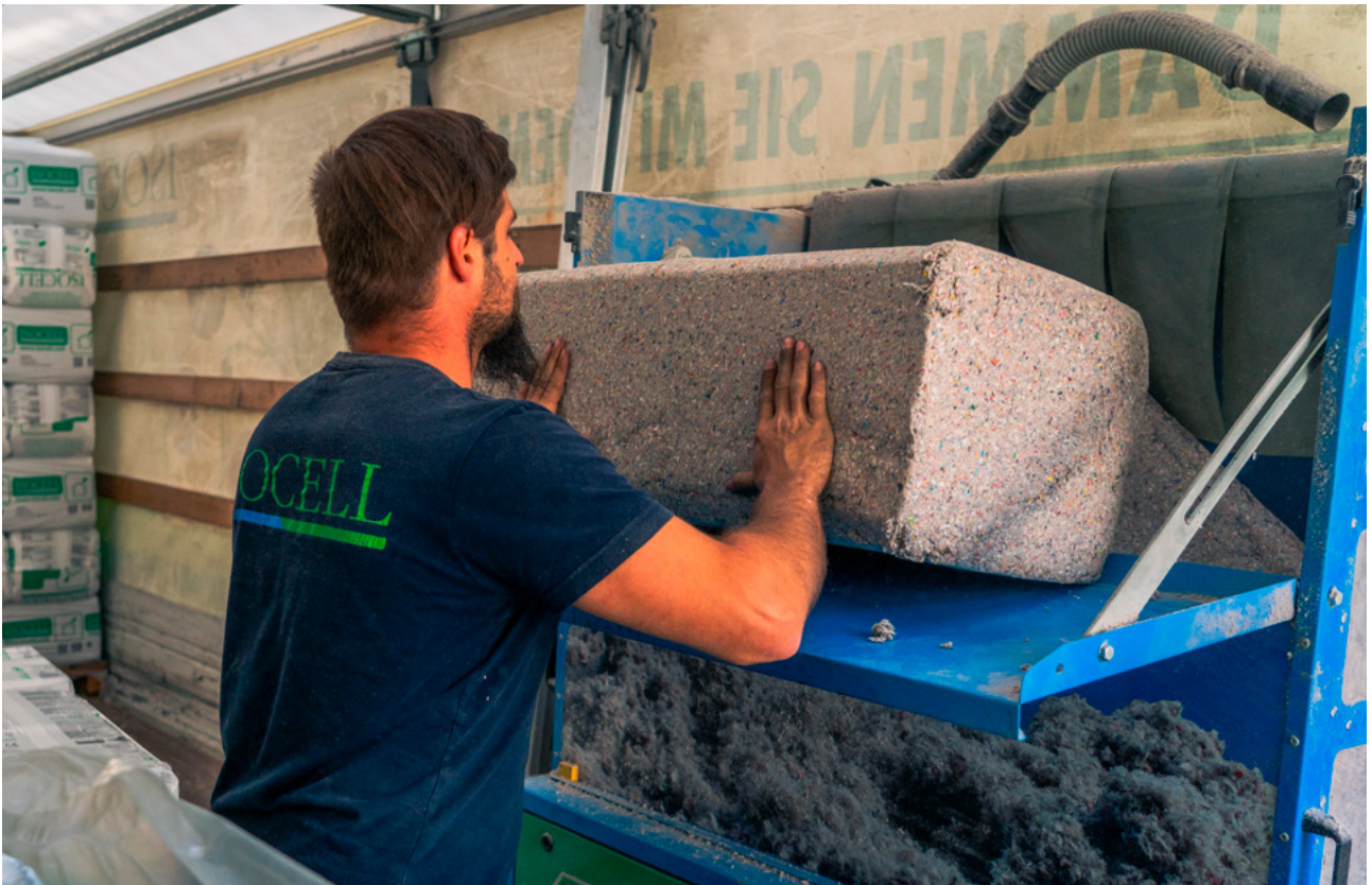
Weiterverarbeitung und Vorbereitung der komprimierten Einblasdämmung auf der Baustelle.
